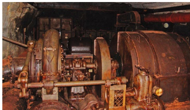
Машина II, спиральная турбина Voith, Фрэнсиса с генератором, Siemens & Halske и контроллером турбины, состояние 2024 г.
