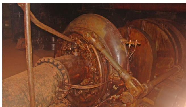
Машина II, спиральная турбина Фрэнсиса, Voith, вид на направляющий аппарат, состояние 2024 г.
