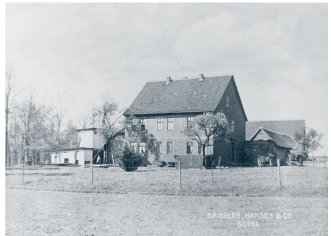
Versuchsanstalt Sundhausen bei Gotha - Außenansicht (die Versuchsanstalt befand sich in dem linken Gebäude)[7]
