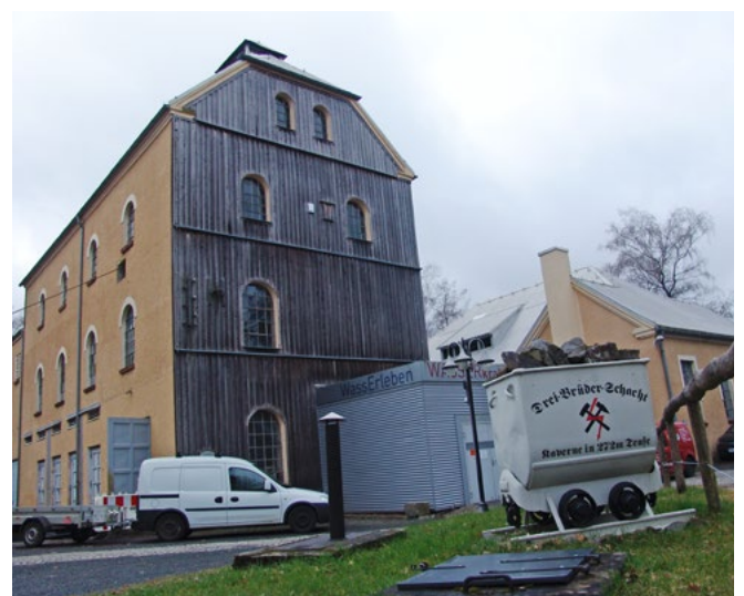
Tagesanlage des Drei-Brüder-Schachts, 2024
